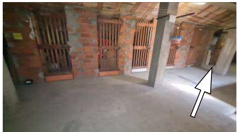
Solaio di pertinenza
